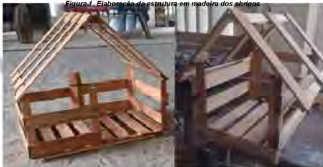
Figura 1. Elaboração da estrutura em madeira dos abrigos
