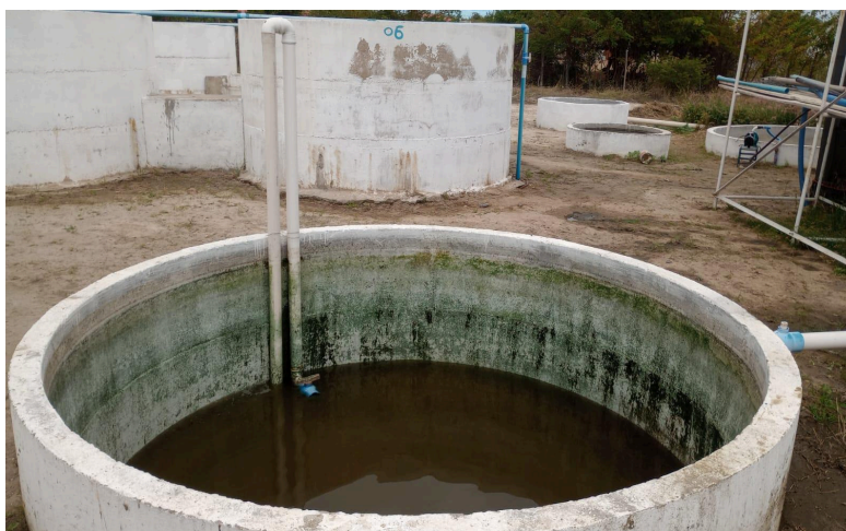
Imagem 24: Ajuste finalizado no filtro decantador.
