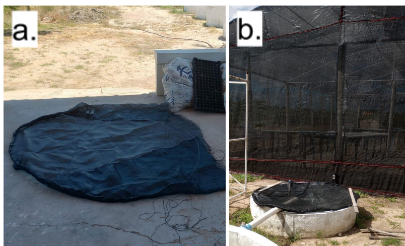
Imagem 18: a) Confeção da cobertura; b) Acomodação da cobertura para o filtro biológico.
