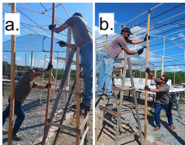
Imagem 9: a) Processo de revitalização das colunas da estufa; b) Fixação dos arames nas colunas da madeira.
