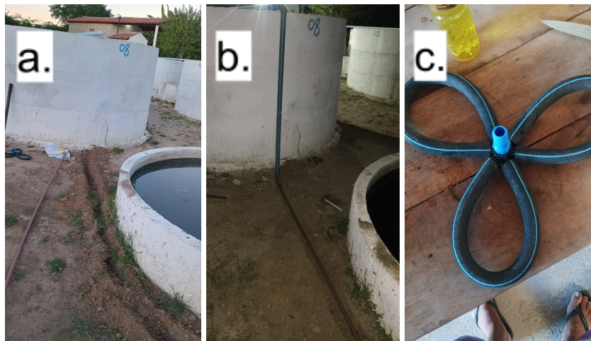
Imagem 21: a) Escavação para posicionamento da tubulação; b) Tubulação posicionada; c) Mangueira porosa confeccionada para o posicionamento.
