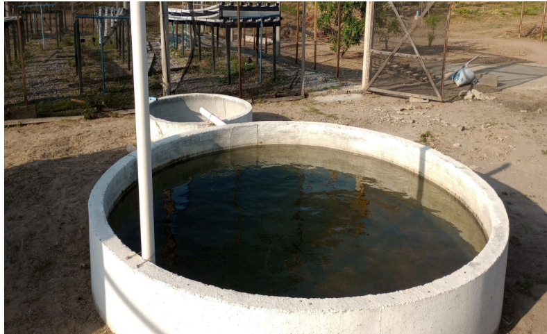
Imagem 6: Filtro decantador do sistema de aquaponia CCBA-Itacuruba (PE).
