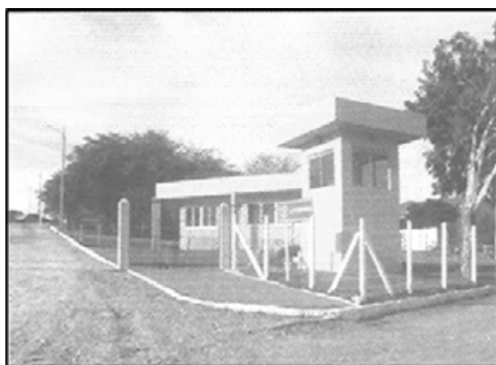
Aterro Sanitário. Acervo do autor.
