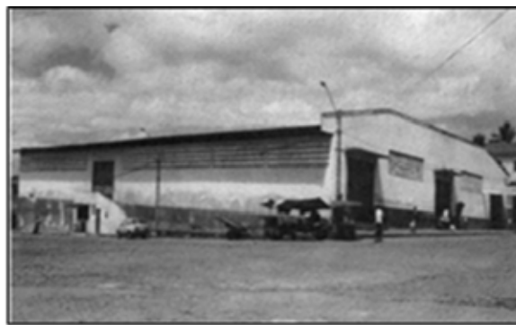
CEALA - Centro de Abastecimento de Lajedo (acervo da Prefeitura de Lajedo)
