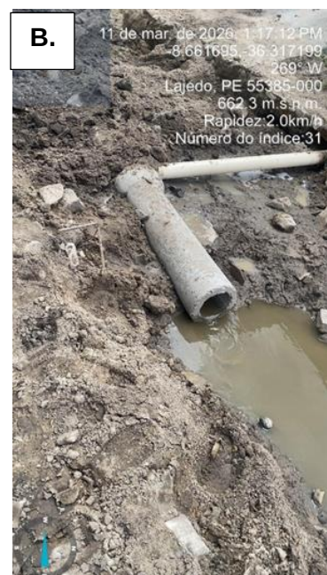
Figura 9 – Substituição estrutural (A) e readequação de materiais (B) na rede de microdrenagem pluvial urbana, registrando a introdução de condutos rígidos de concreto na rede de drenagem urbana.
