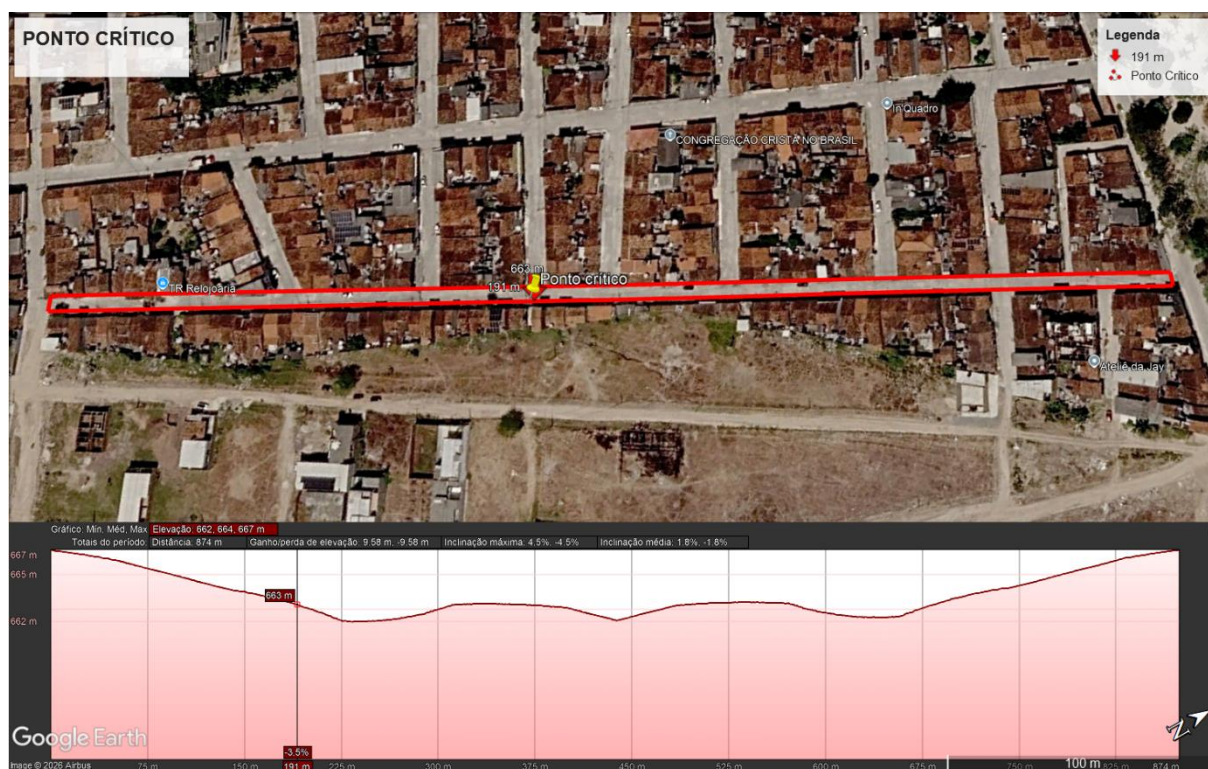
Figura 19 – Localização do ponto crítico de drenagem urbana no Bairro Abraão Veloso, em Lajedo-PE.
