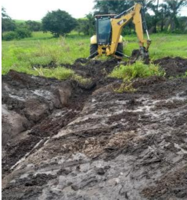
Imagem 9. Operação agrícola para construção dos drenos. Fonte: Álvaro Carlos.
