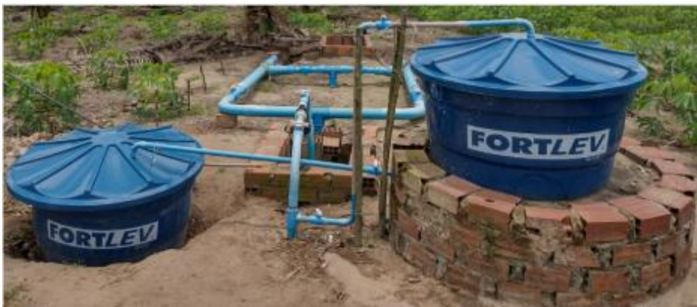
Imagem 3. Sistema fixo, utilizado para irrigação e fertirrigação. Fonte: Autor.
