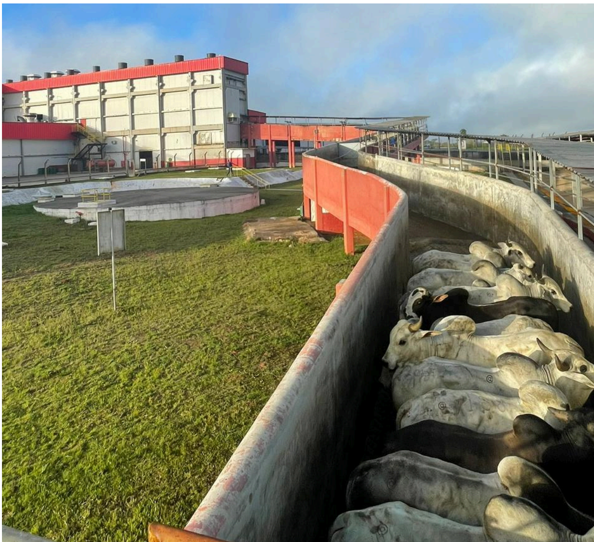
Figura 4 - Rampa de acesso à sala de abate.
