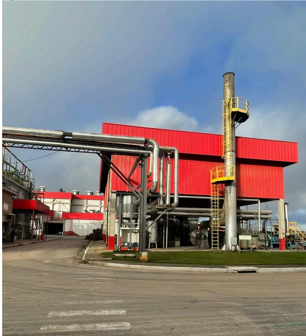
Figura 6 - Visão externa da área da caldeira.
