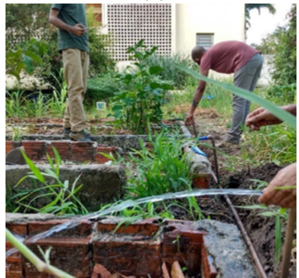
Escola Viva - Instalação de Sistema de Irrigação - 2019
