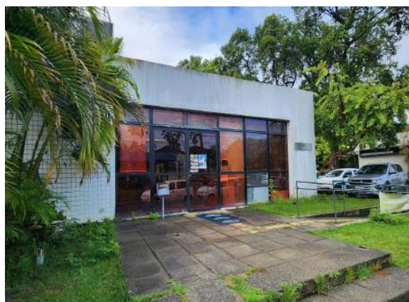
Figura 2. Fachada prédio Anexo da ADAGRO.
