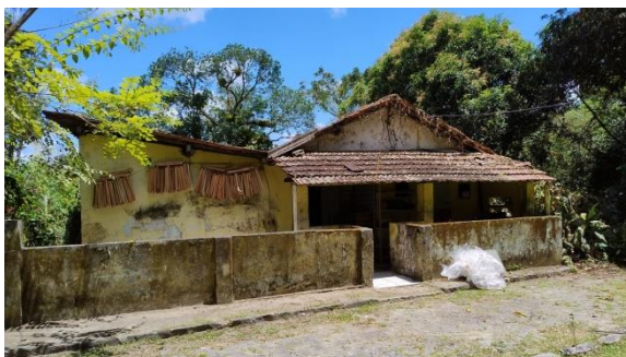
Figura 2 – Casa de apoio Meliponário
