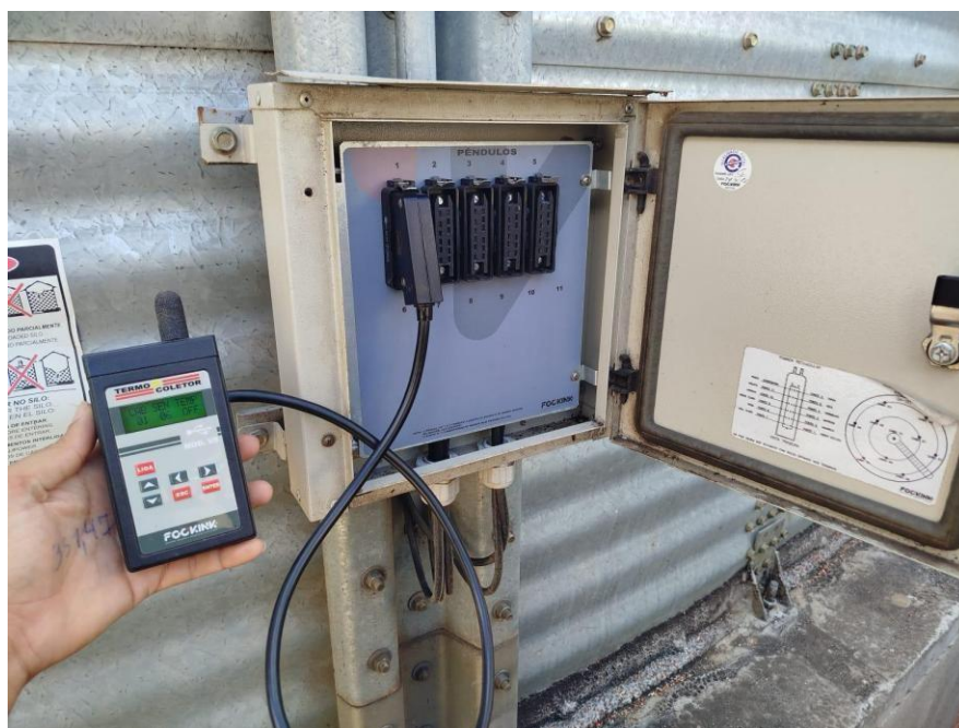
Figura 8: Monitoramento da temperatura dos silos de matérias-primas na fábrica de ração.
