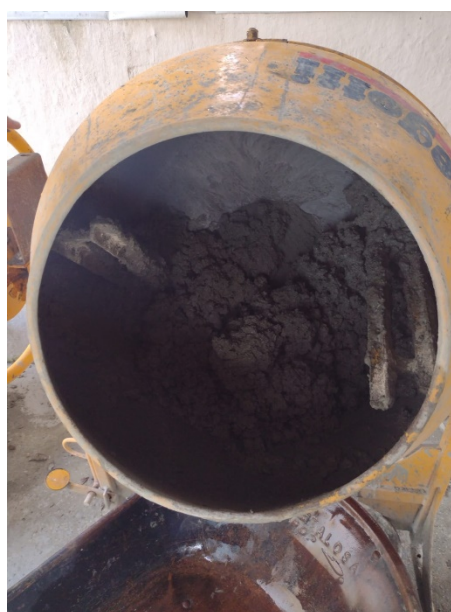
Figura 21: Mistura do concreto.
