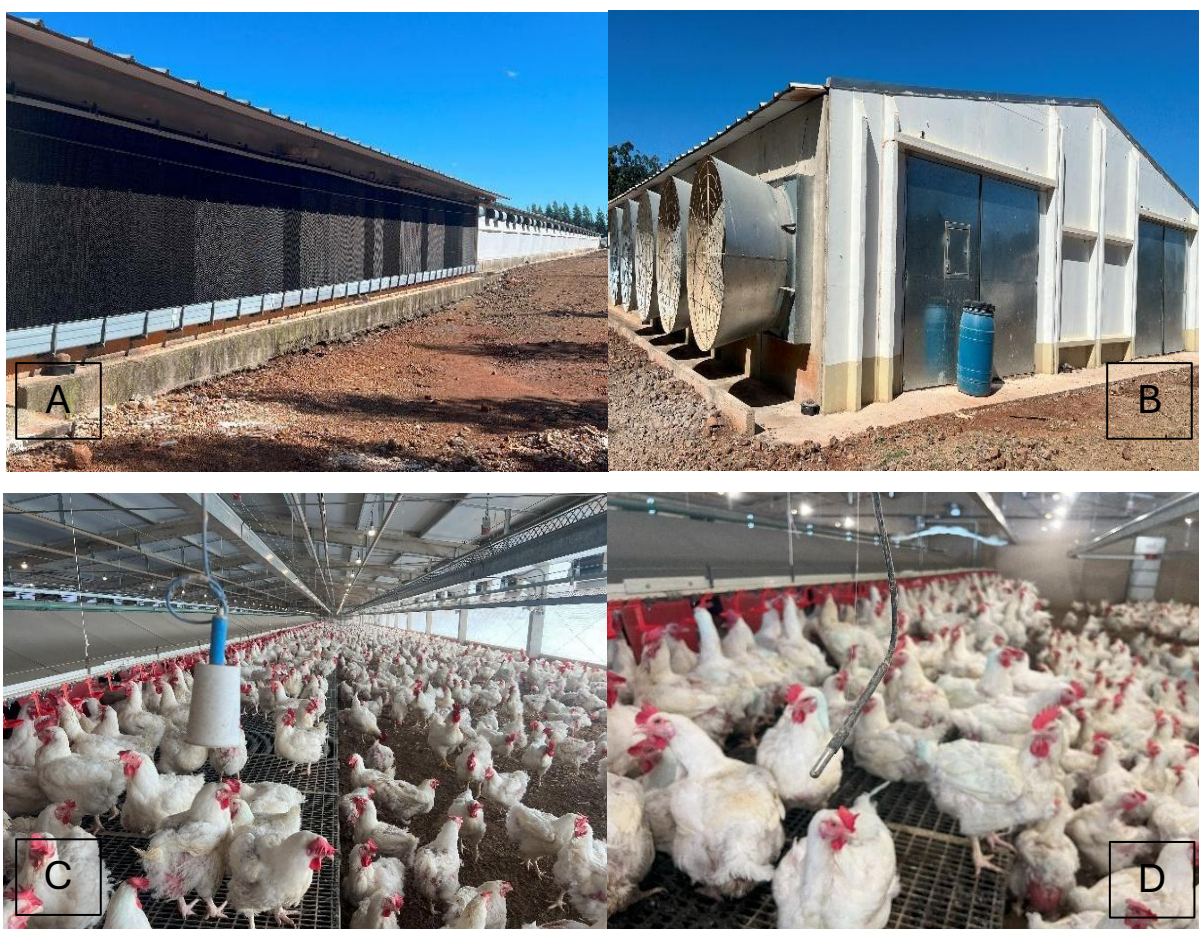
Figura 25 – (A) Visão externa do galpão, com painel evaporativo de celulose. (B) Visão externa do galpão com exaustores e balde de descarte de aves mortas. (C) Visão interna do galpão, com sensor de umidade. (D) Visão interna do galpão, com sensor de temperatura. Fonte: Arquivo pessoal, 2025 (Autorizado pela empresa).
