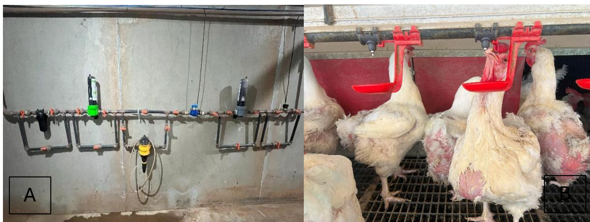
Figura 28 – (A) Visão externa do galpão, com sistema de água da esquerda para direita com: filtro, dosadores de pH, medicamento, hidrômetro analógico, dosador de cloro e hidrômetro digital. (B) Visão interna do galpão, demonstrando ave em bebedouro tipo nipple. Fonte: Arquivo pessoal, 2025 (Autorizado pela empresa).
