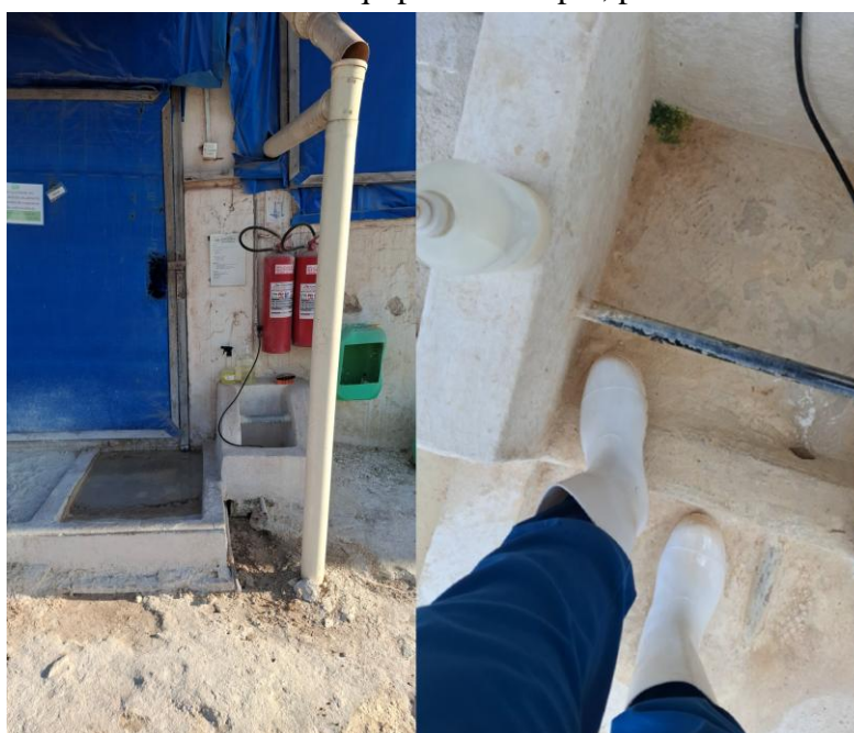
Figura 21. Entrada dos aviários equipados com pia, pedilúvio e lavabotas.
