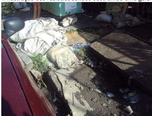
Figura 4. Ilustração dos resíduos sólidos obstruindo uma galeria, 2015
