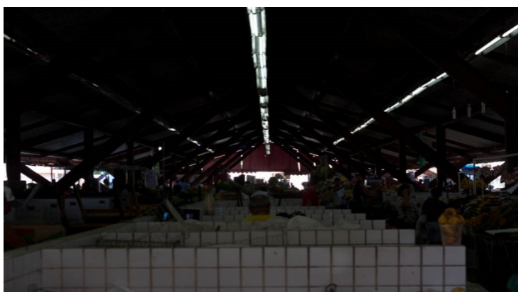
Figura 8. Iluminação precária de um dos galpões.
