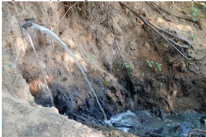
Figura 1: Despejo de esgotos sem tratamento no rio Pajeú.
