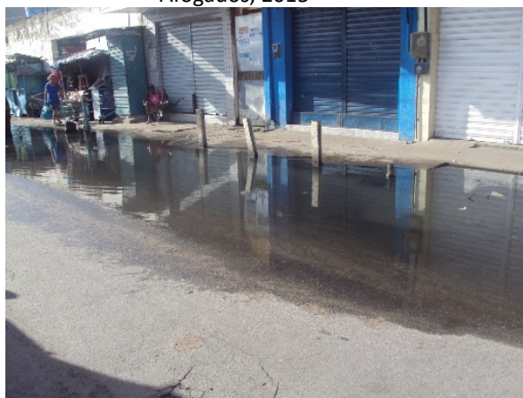
Figura 5. Ilustração do ineficiente escoamento da água pluvial no entorno da feira livre do Mercado de Afogados, 2015
