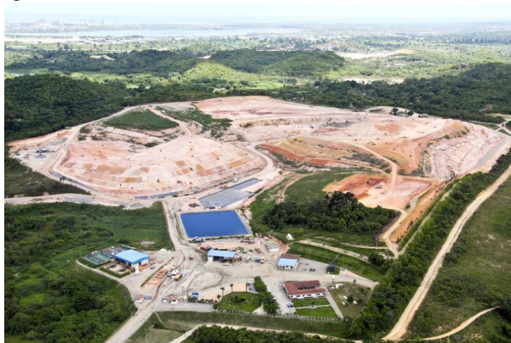
Figura 8. Vista aérea do Centro de Tratamento de Resíduos Candeias
