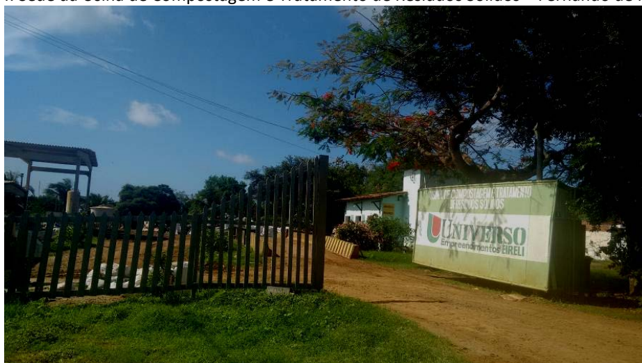
Figura 4. Sede da Usina de Compostagem e Tratamento de Resíduos Sólidos – Fernando de Noronha
