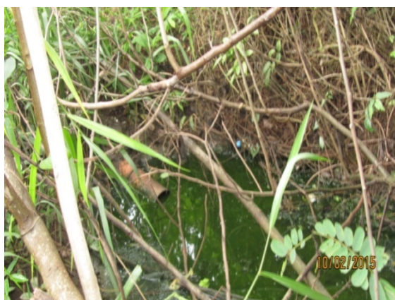
Figura 2. Lançamento de efluentes da ETE dentro do terreno.
