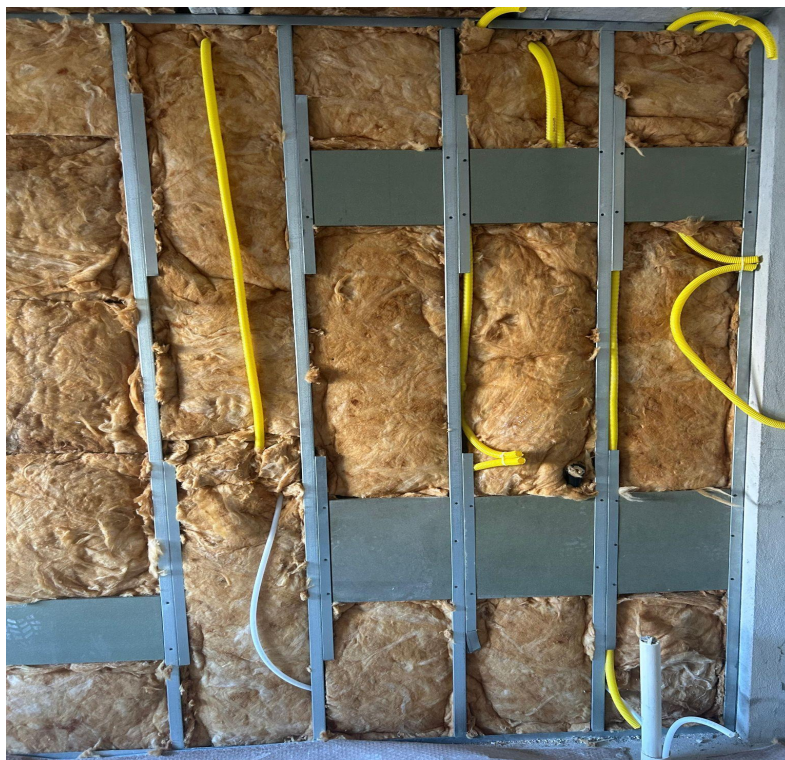
Figura 22 – Instalação isolante termoacustico
