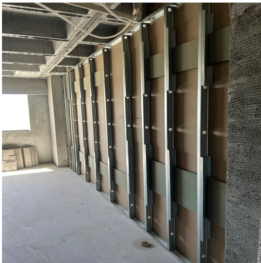
Figura 20 – Fixação de reforço
