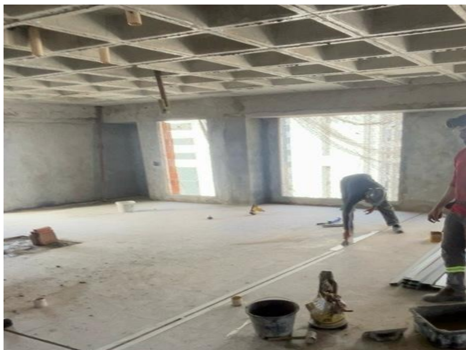
Figura 14 – Pavimento pronto para receber o Drywall
