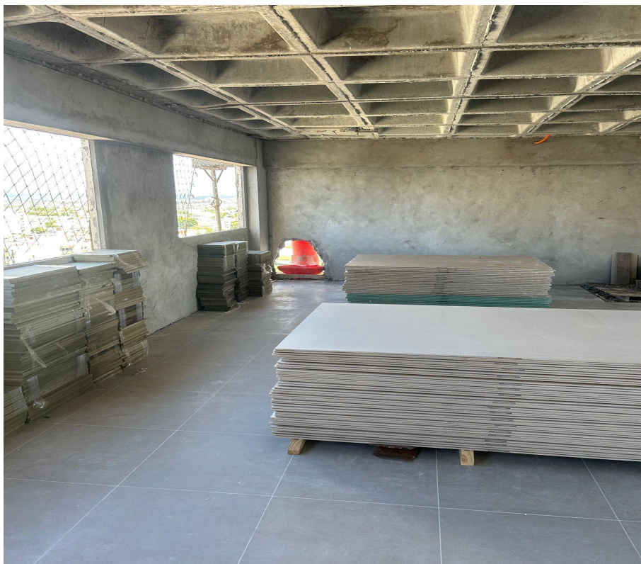
Figura 12 – Armazenamento Chapas Drywall
