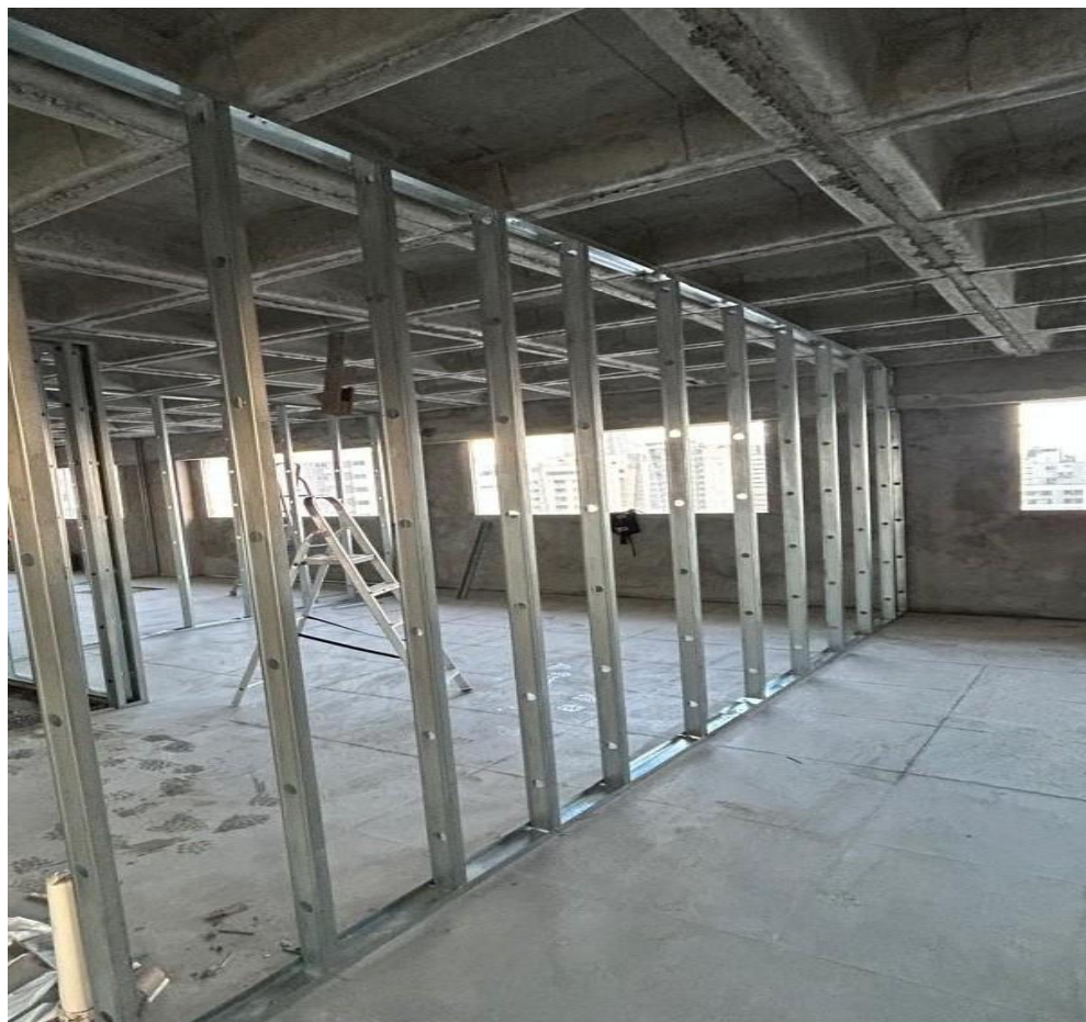
Figura 17 – Estrutura montantes
