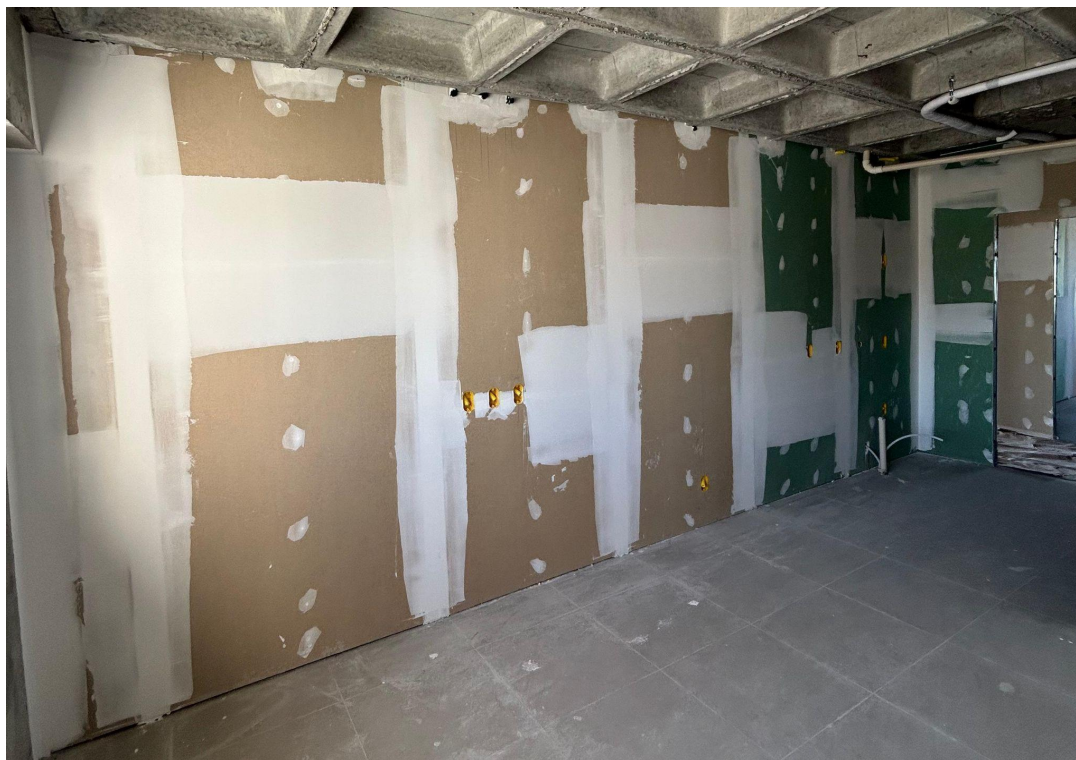
Figura 23 – Tratamento de juntas e parafusos
