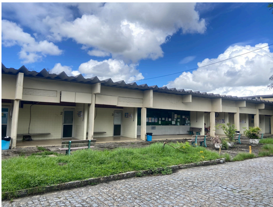
Figura 1. Entrada do Hospital Veterinário da UFRPE
