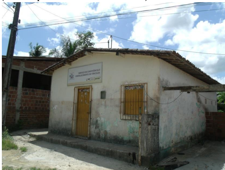
Figura 7 – Centro de Convivência e Fortalecimento de Vínculos (localizado próximo ao centro da comunidade)
