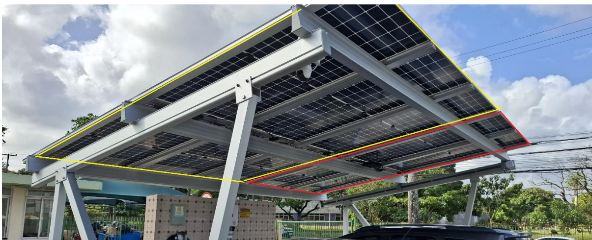
Figura 16 – Foto da instalação da usina fotovoltaica.
