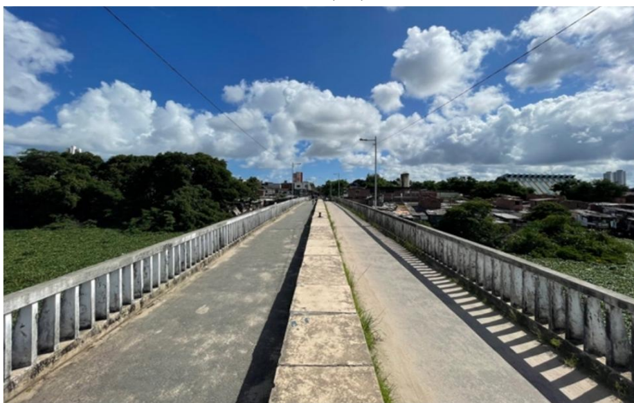
Figura 3 – Ponte para Pedestres Emocy Krause, acesso ao Parque Santana Ariano Suassuna, Recife (PE).
