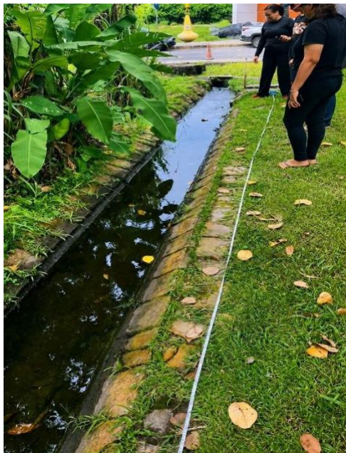
Figura 8. Avaliação da profundidade do canal de abastecimento de água na Base de Pesca da UFRPE. (Fonte: Acervo pessoal.)
