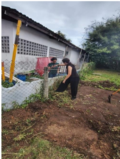
Figura 5. Preparação da área externa para instalação das estruturas experimentais. (Fonte: Acervo pessoal)
