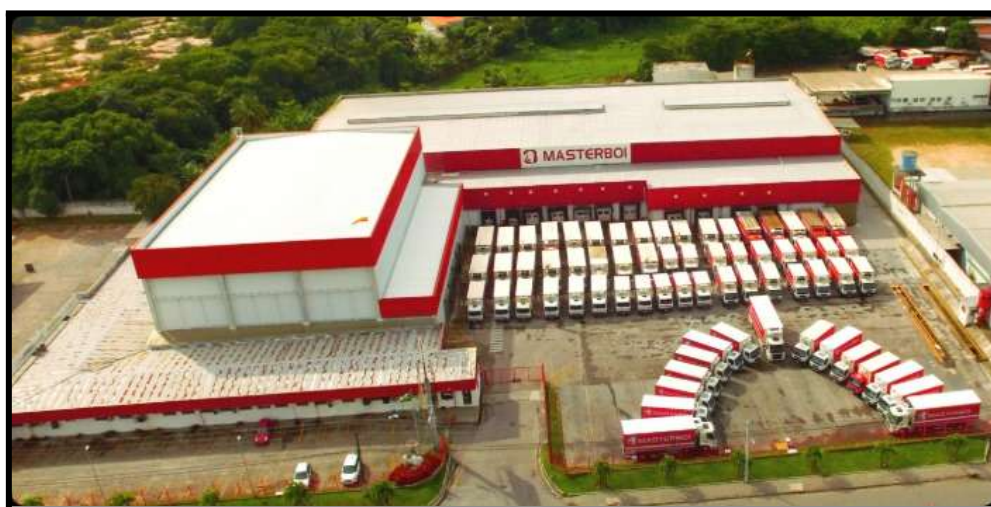
Figura 1. Centro de Distribuição e Processamento Masterboi em Recife-PE.
