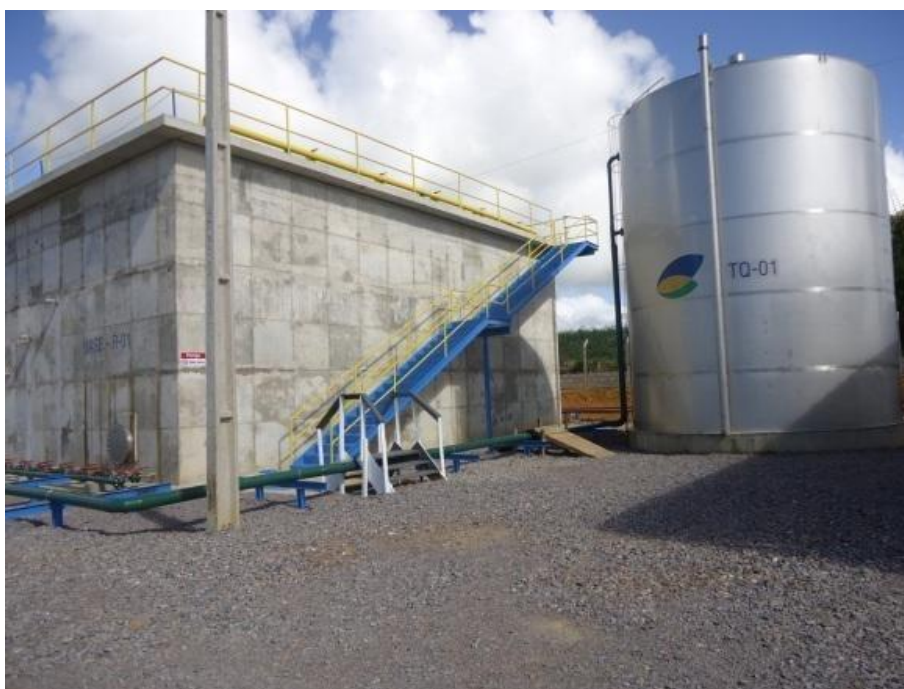
Figura 5 – Reator anaeróbio tipo UASB
