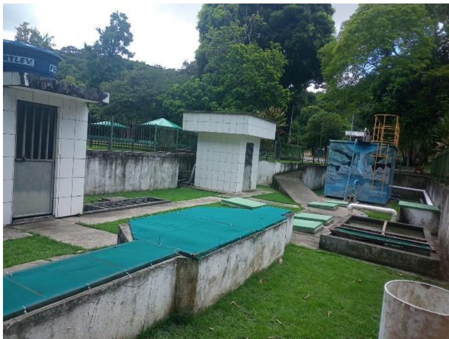
Figura 7 – Estação de tratamento Dois Irmãos
