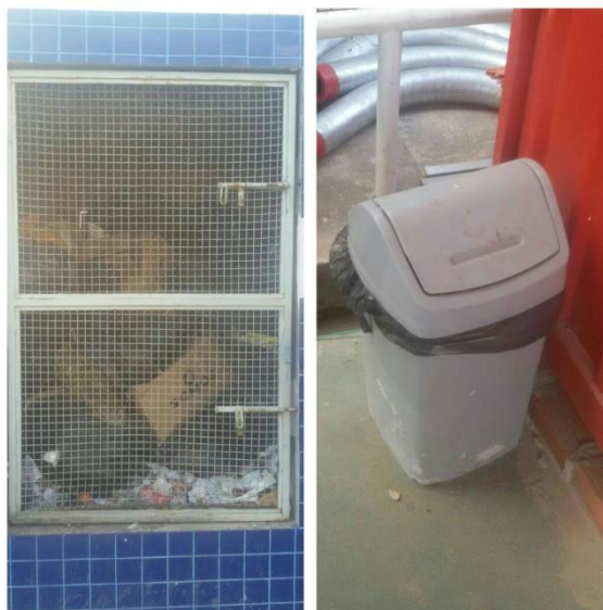
Figura 1. Acondicionamento inicial e temporário dos resíduos da administração do canteiro de obras
