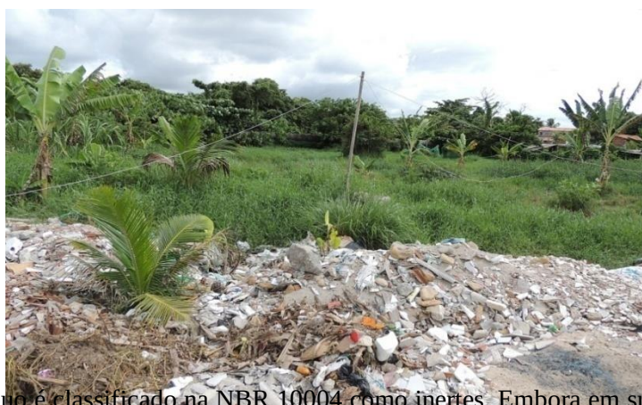
Figura 3. Resíduos sólidos da construção civil e demolição.
