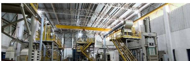
Figura 61. Estrutura interna do galpão de beneficiamento de algodão do IMA (algodoeira)
