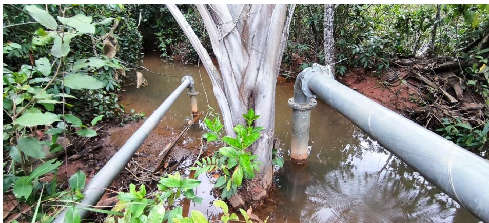
Figura 75. Fonte de abastecimento de água do CT Rondonópolis através de outorga de água do Rio Lourencinho
