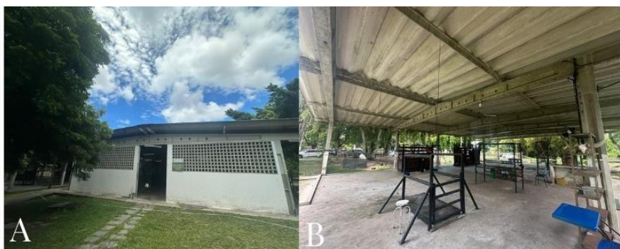
Figura 1. Prédio central de atendimento no AGA/HVU/DMV/UFRPE (A). Anexo ao lado do prédio central, contendo os bretes e troncos (B).
