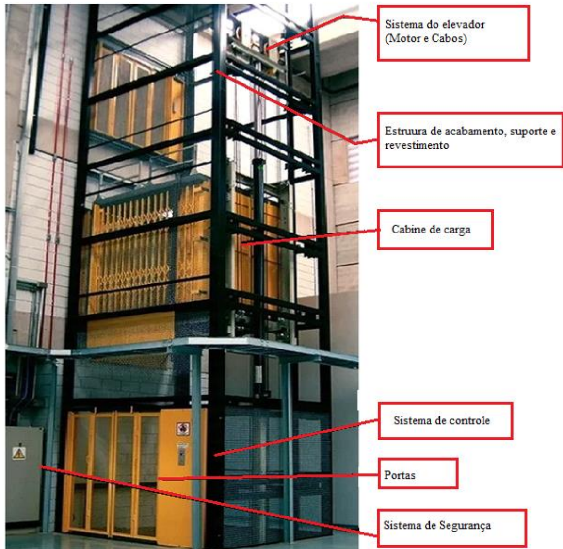
Figura 7 - Principais partes de um elevador de carga comercial
