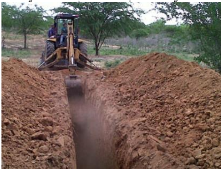
Figura 2 - Escavação mecanizada pela metodologia VCA.
