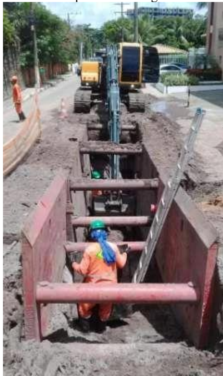
Figura 3 - Escavação mecanizada pela metodologia VCA com uso de escoramento.
