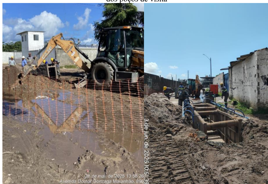
Figura 21 - Entroncamentos das redes existentes tanto do lado de Prazeres quanto de Cajueiro Seco e elevação dos poços de visita
