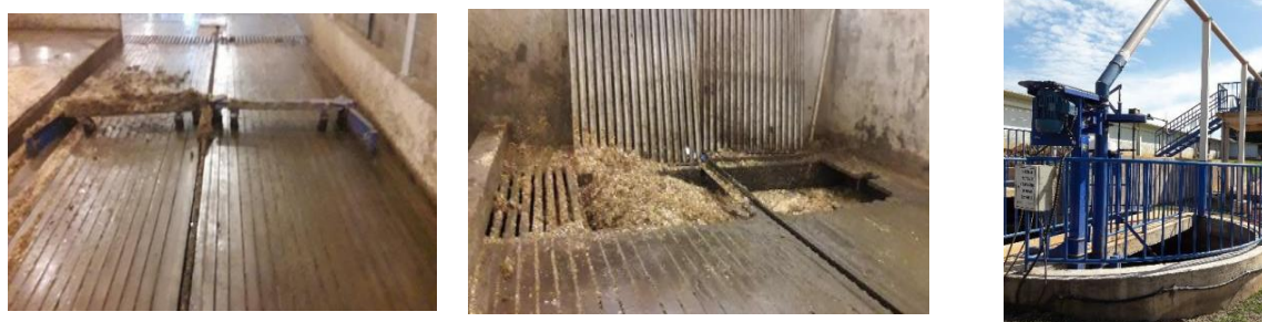
Figura 25. Scraper, canaleta e poço de fezes.
