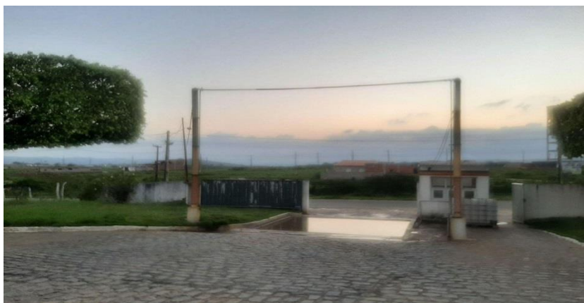
Figura 14 - Acesso através de arco de aspersão e rodolúvio, e entrada de pedestres. Fonte: Arquivo pessoal, 2025. (Autorizado pela empresa)
