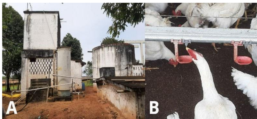
Figura 11 - (A) Unidade de tratamento de água. (B) Bebedouro tipo nipple Fonte: Arquivo pessoal, 2025. (Autorizado pela empresa)
