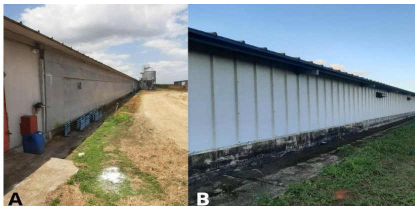
Figura 30 - (A) Visão externa do aviário pressão negativa com lonas nas laterais. (B) Visão externa do aviário pressão negativa com isopainel nas laterais. Fonte: Arquivo pessoal, 2025. (Autorizado pela empresa)
