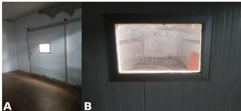
Figura 17 - (A) Porta de recebimento de ovos. (B) Caçamba de caminhão em posição para descarga de ovos. Fonte: Arquivo pessoal, 2025. (Autorizado pela empresa)
