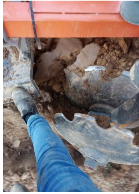
Figura 48 – Acompanhamento in loco
