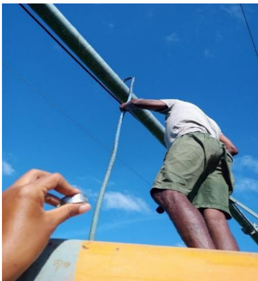
Figura 32 – Reposição de braçadeira
