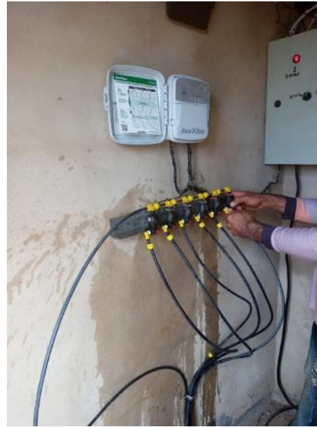
Figura 67 – Ajuste dos selenóides
