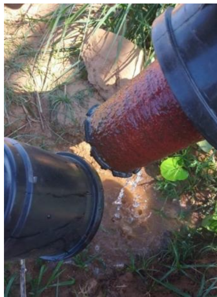
Figura 43 – Filtro da bomba que capta água do rio Figura 44 – Limpeza do filtro do rio
