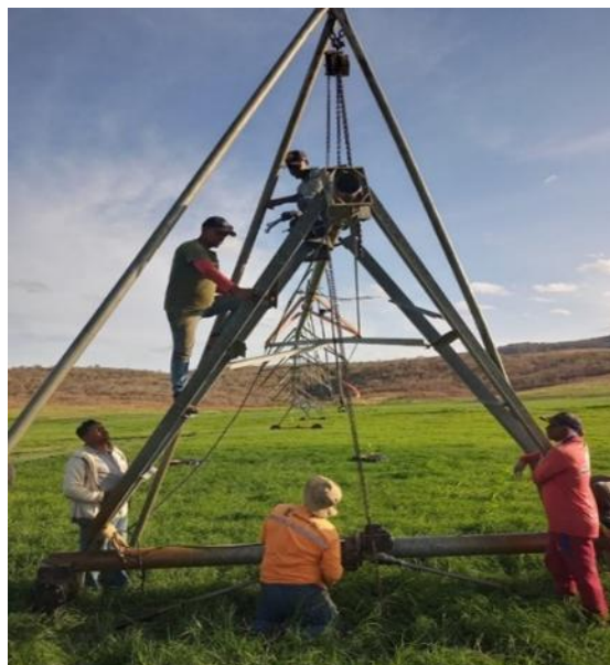
Figura 29 – Peças sendo retiradas e repostas
