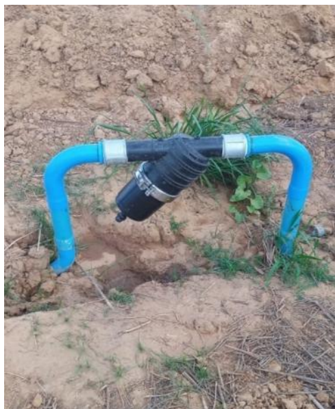
Figura 43 – Filtro da bomba que capta água do rio Figura 44 – Limpeza do filtro do rio
