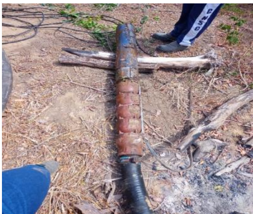
Figura 35 – Conserto da bomba do banco de mudas
