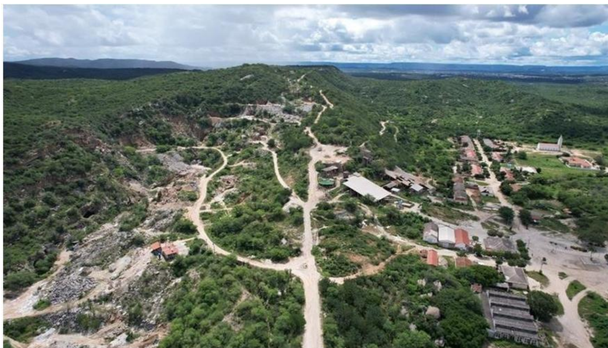
Figura 1 – Mina Brejuí, localizada em Currais Novos, Rio Grande do Norte, vista por drone.
