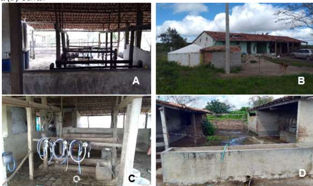
Figura 06: Instalações (A) Sala de ordenha (B) Casa Sede e cisterna (C) Sala de Ordenha (D) Curral.
