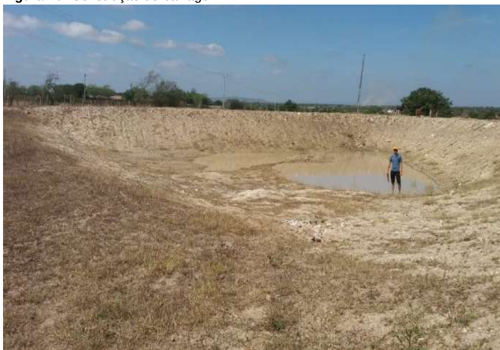
Figura 10: Construção de barragem
