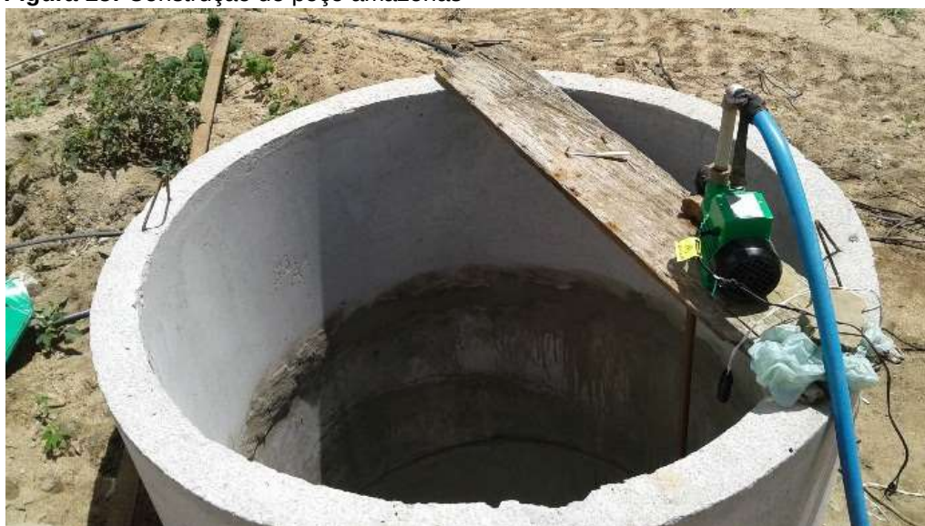
Figura 15: Construção de poço amazonas
