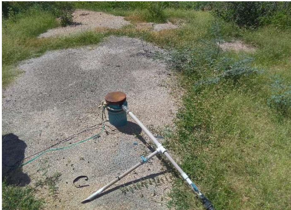
Figura 14: Implantação de poço artesiano
