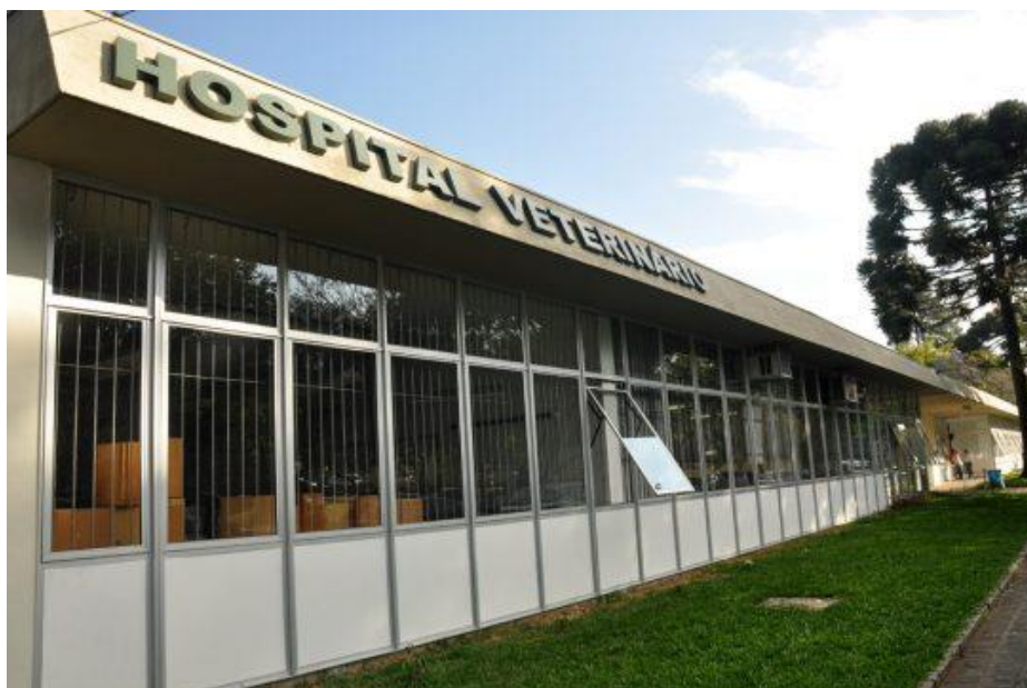
Figura 1. Hospital Veterinário da UFPR. Fonte: Site da UFPR. Disponível em: https://homologa.ufpr.br/hospital-veterinario-mantem-atendimento-a-comunidade-apesar-dos-cortes-de-verbas/ . Acesso em: 15 set. 2023.
