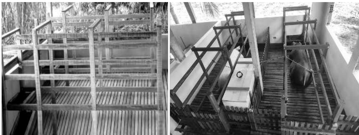
Figura 78. Galpão maternidade em alvenaria com celas parideiras e piso ripado de madeira
