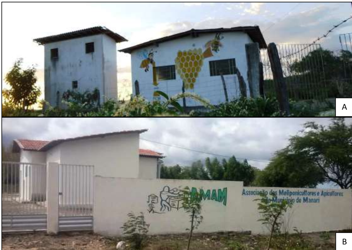
Figura 03. Casa de mel antes da reforma (A) e casa de mel/ entreposto depois da reforma (B) da associação AMAM, Manari– PE. Fotos: P. A. Oliveira, 2012; M. S. Sá, 2019.
