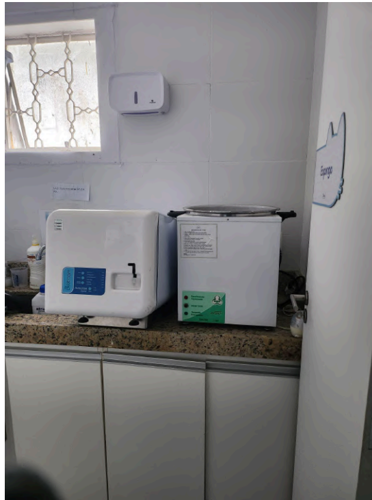
Figura 29 - Sala de esterilização da Chatterie, em Recife/Pernambuco.
