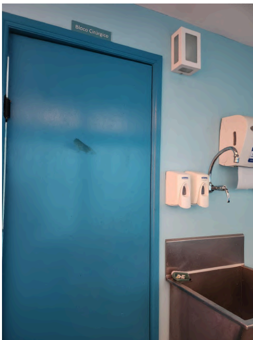
Figura 12 - Entrada do bloco cirúrgico.
