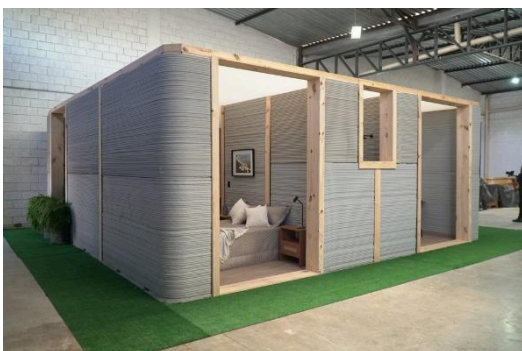
Figura 2 – Protótipo em Nova Lima, na Grande Belo Horizonte
