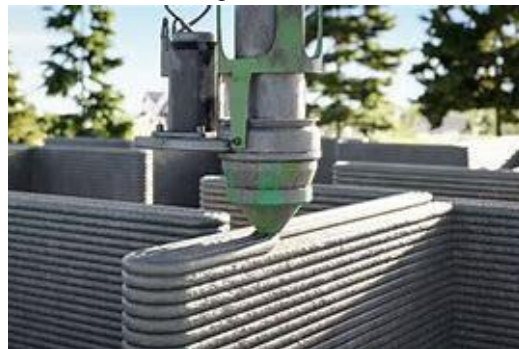
Figura 3 – Processo de extrusão de concreto em impressão 3D
