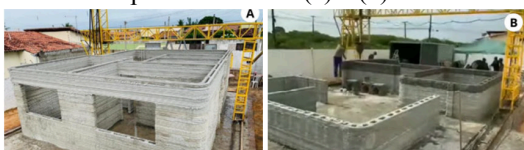
Figura 1 – Vista do processo de impressão das paredes da casa (a) e (b)
