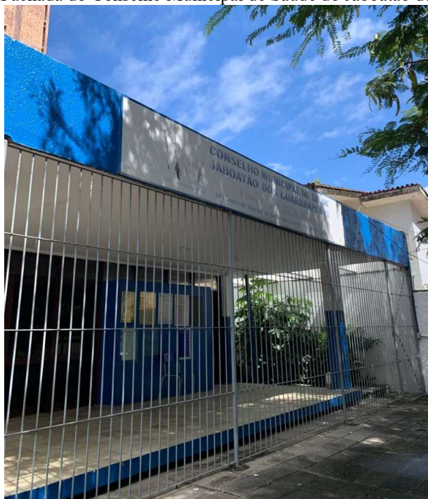
Figura 14 - Fachada do Conselho Municipal de Saúde do Jaboatão dos Guararapes
