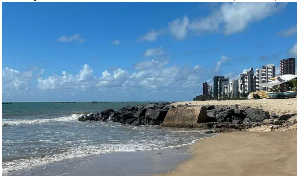
Figura 16 - Enrocamento na Praia de Piedade (Trecho 3)
