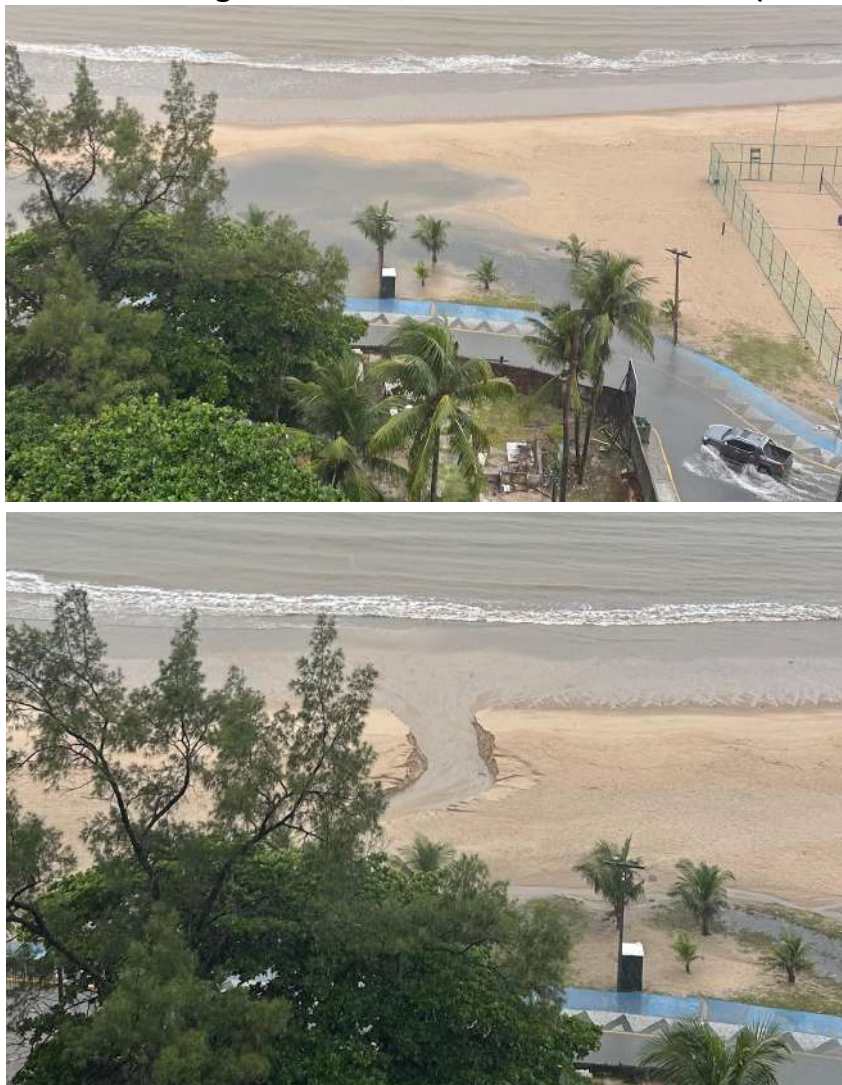
Figura 20 - Drenagem Ineficiente da Orla de Piedade (Trecho 3)
