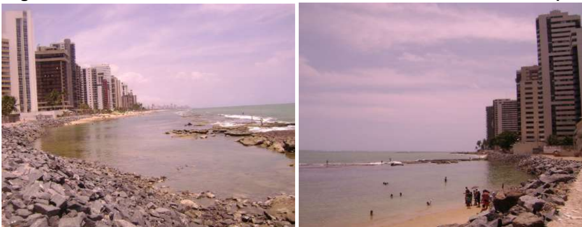
Figura 9 - Enrocamento na Praia de Piedade em Jaboatão dos Guararapes
