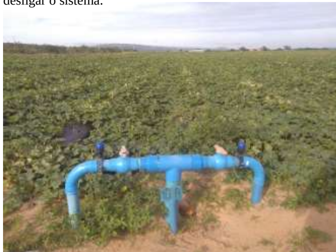
Figura 8: Cavalete de irrigação com registros para ligar e desligar o sistema.
