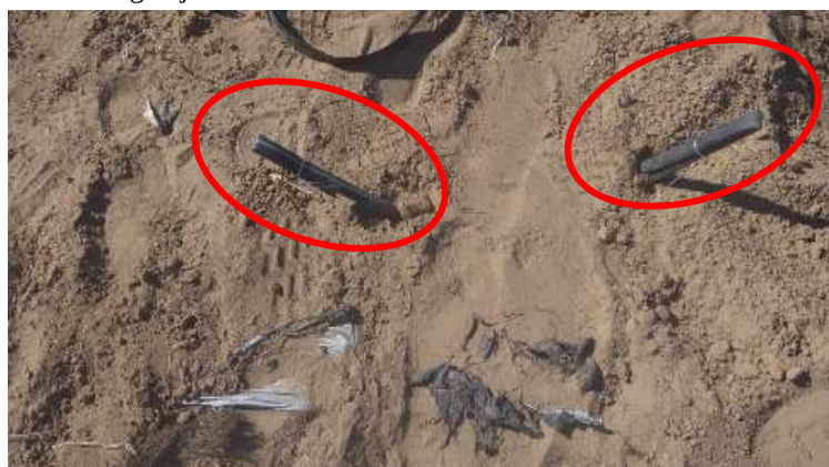
Figura 9: Chicotes que fazem a conexão entre as linhas secundárias e as fitas de gotejamento
