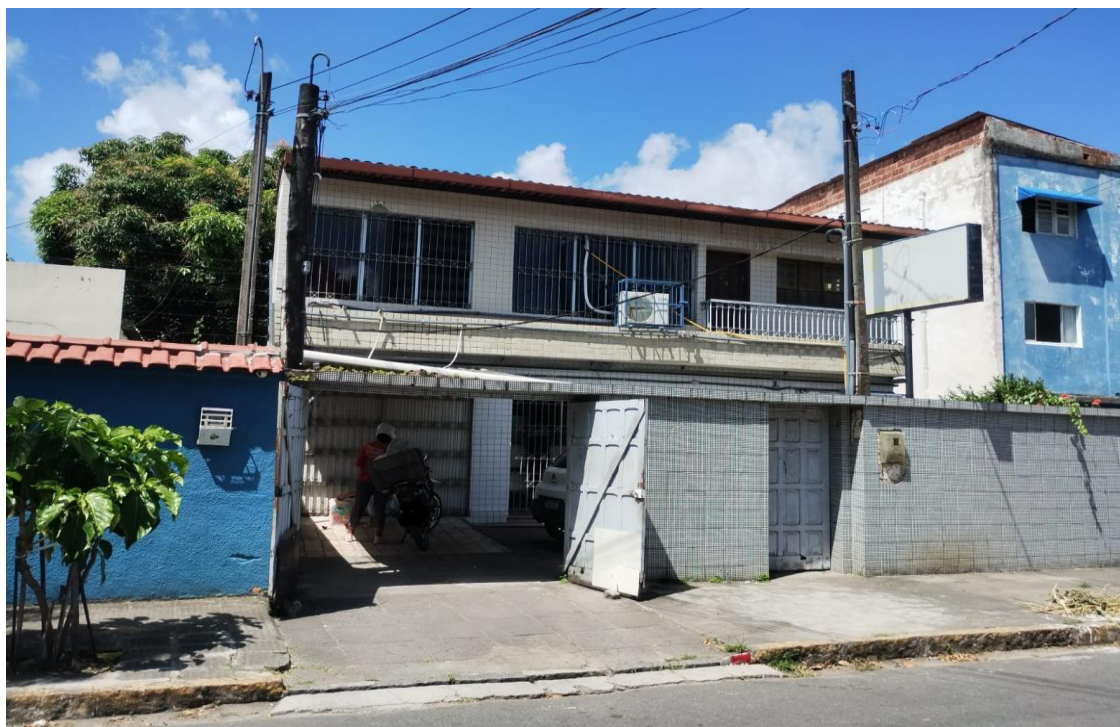
Figura 1: Visão externa da sede do Distrito Sanitário III. Fonte: Arquivo Pessoal (2025).
