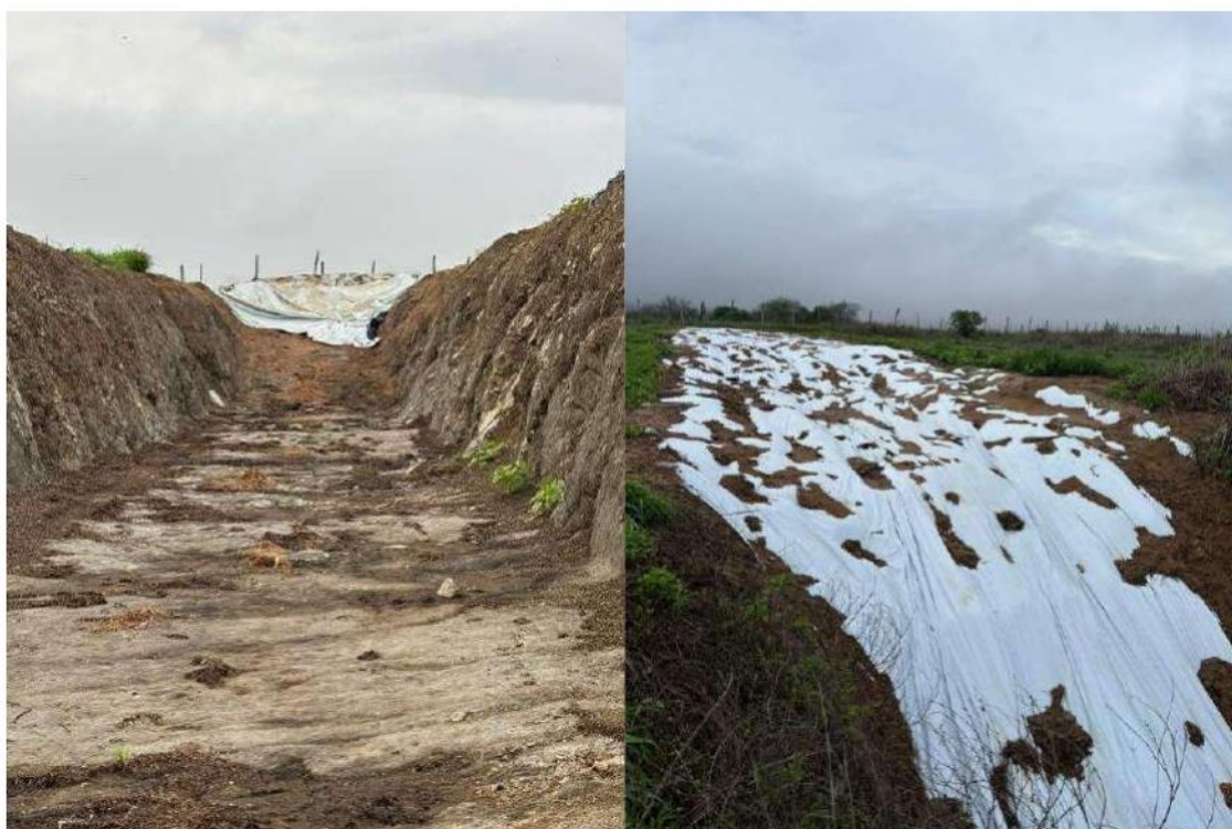
Figura 25. Silo do tipo trincheira.
