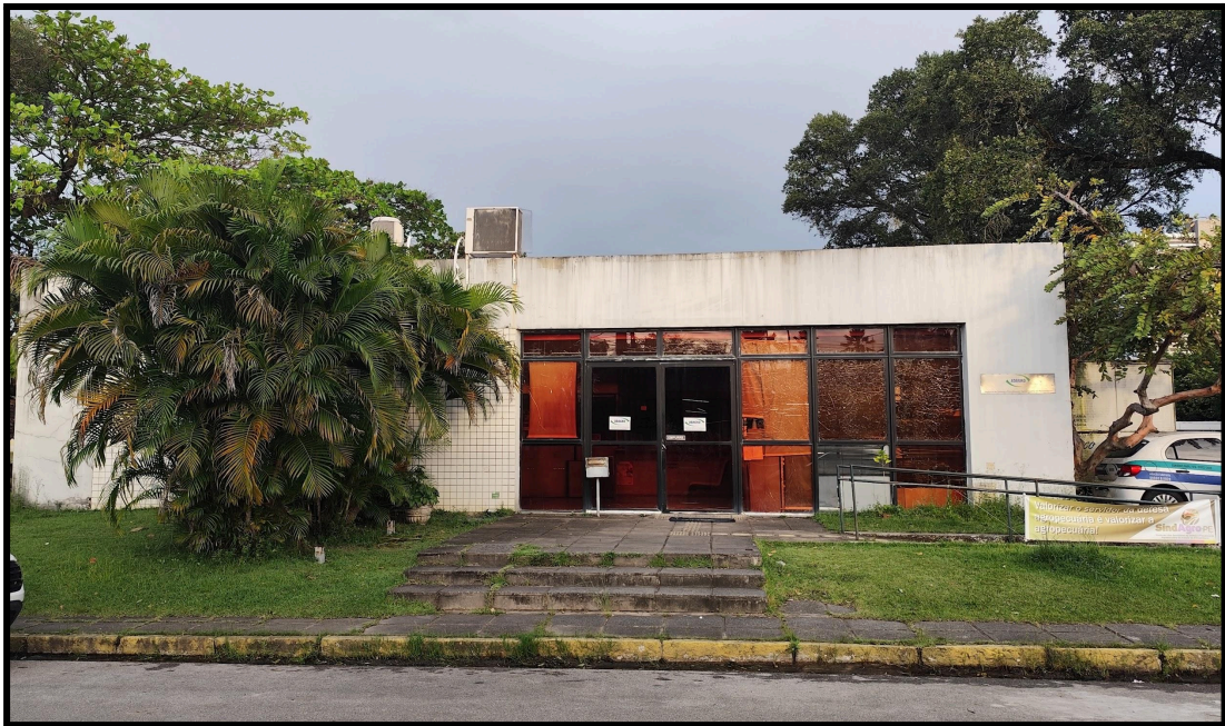
Figura 2. Fachada do Prédio Anexo da ADAGRO.
