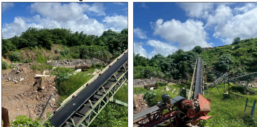
Figura 10 - Visita realizada à CTR - B.
