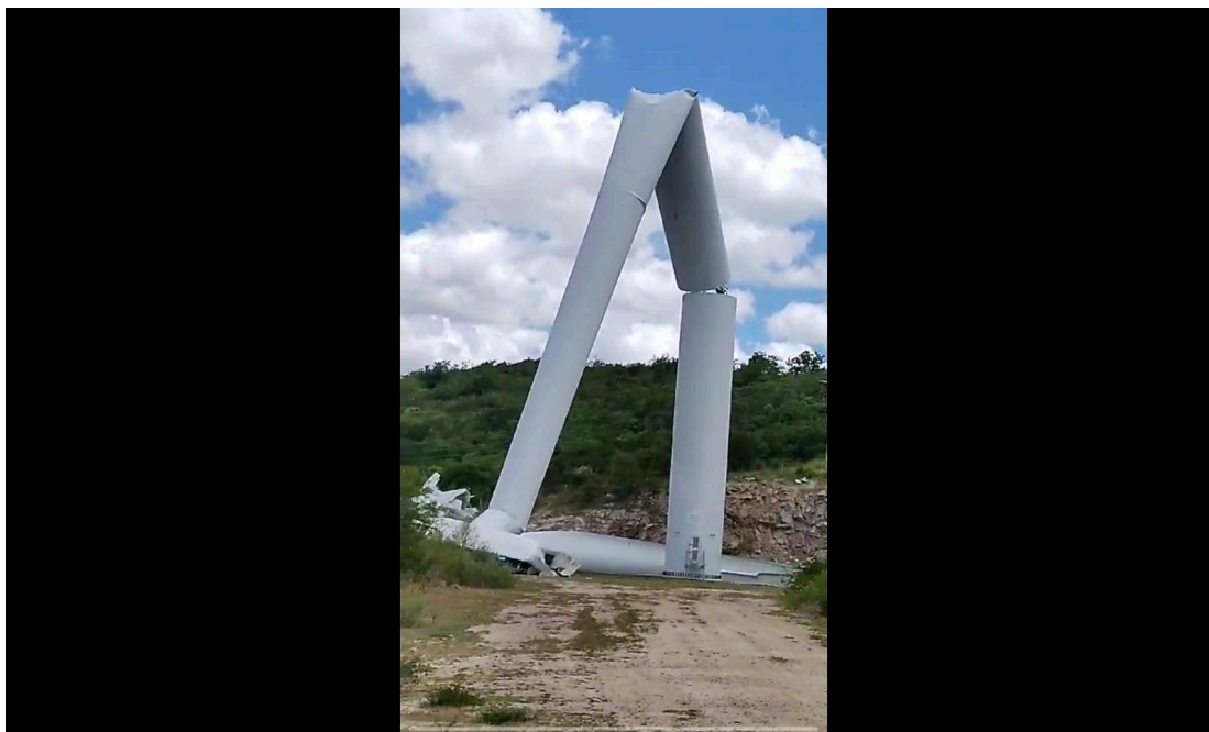
Figura 18 - Print de reprodução de vídeo sobre queda de aerogerador no Complexo Ventos de São Clemente, no município de Caetés - PE.
