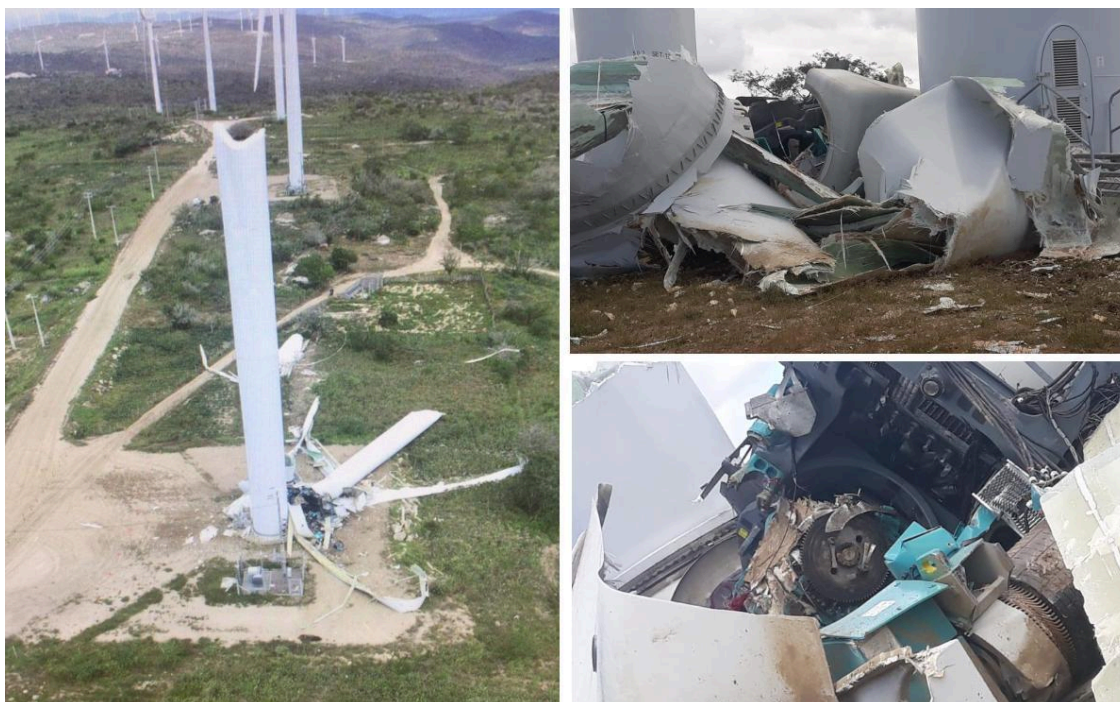
Figura 16 - Aerogerador caído no Complexo Eólico Ventos de São Clemente, Caetés - PE.
