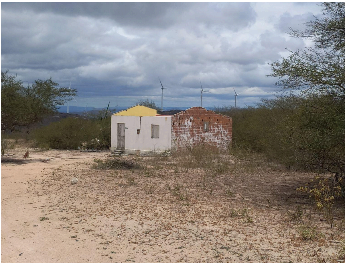
Figura 23 - Casa esvaziada, aguardando a demolição, no Agreste de Pernambuco.
