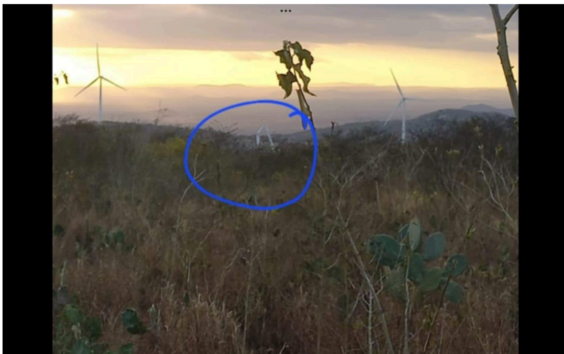
Figura 19 - Aerogerador caído no Complexo Eólico Ventos de São Clemente, Caetés - PE.
