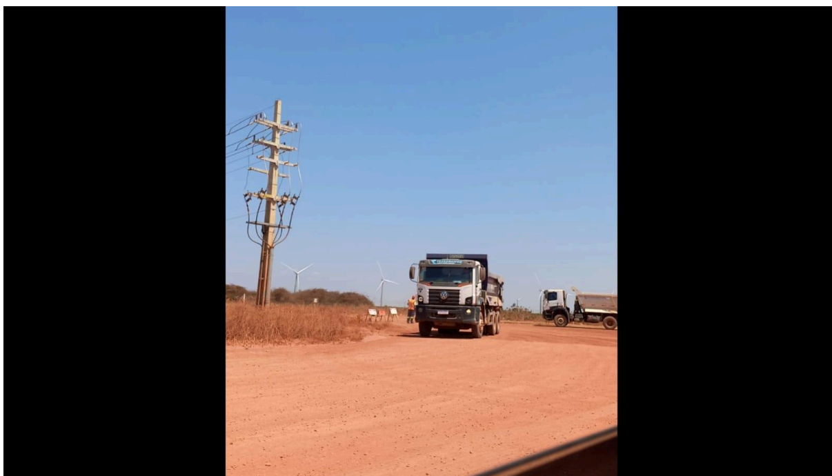
Figura 34 - Caminhões, placas e construções de mais um empreendimento eólico na fronteira entre PE e PI.
