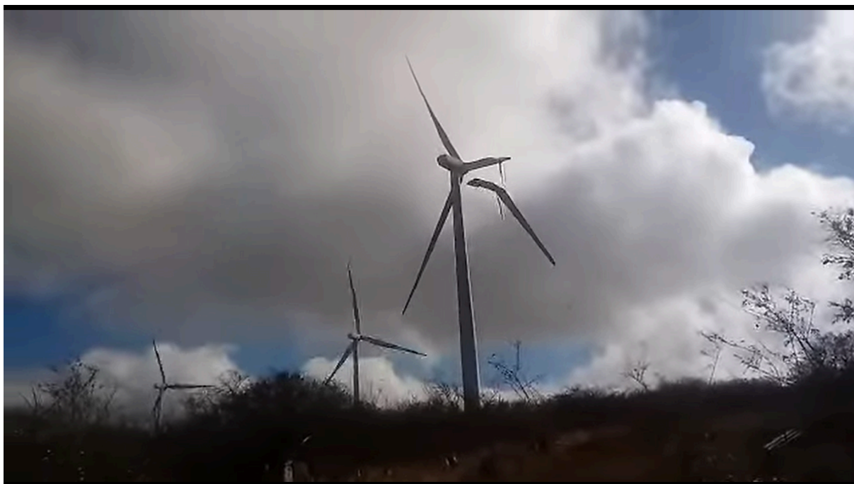
Figura 17 - Print de reprodução de vídeo sobre queda de hélice de aerogerador no Complexo Ventos de São Clemente, no município de Caetés - PE.
