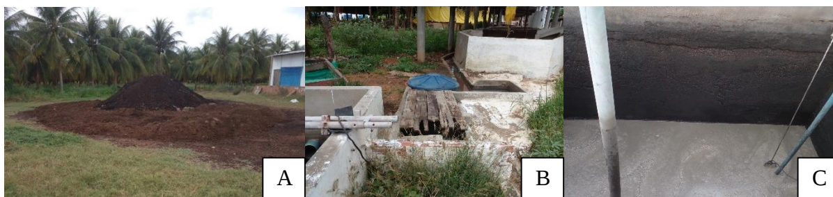
FIGURA 17. Esterqueira (A), decantador (B) e tanque de armazenamento de dejetos (C)
