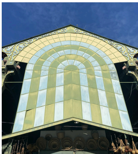
Figura 1: Fachada do Mercado de São José.
