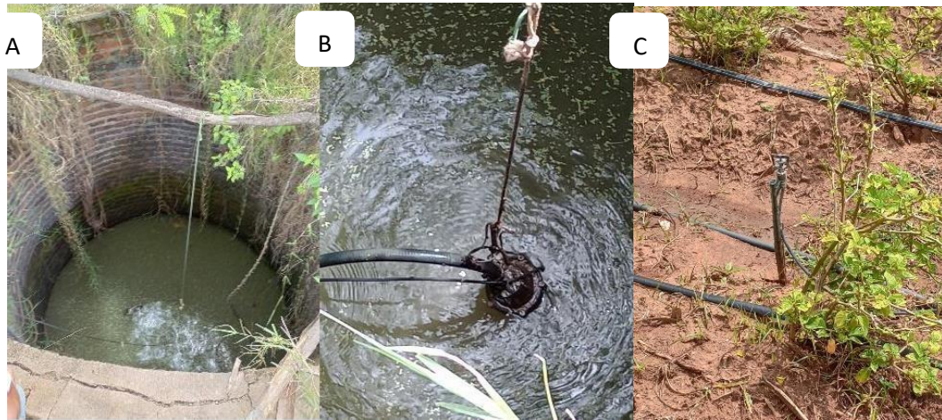
Figura 08 – Detalhe do espelho d'água do poço Amazonas A1 (A e B); sistema de irrigação por microaspersão em funcionamento (C).
