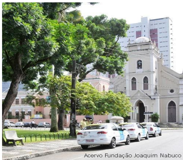
Figura - III Antiga capela do engenho Casa Forte
