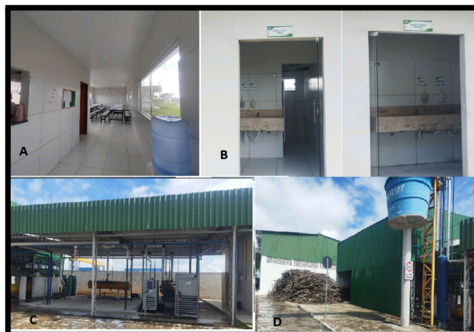
Figura 25. Refeitório (A), Banheiros e Vestiários (B), Banco de gelo e Caldeira da Frutigutti
